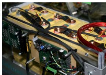
Batterien und Batteriemangement als Kern des Energiespeichers
